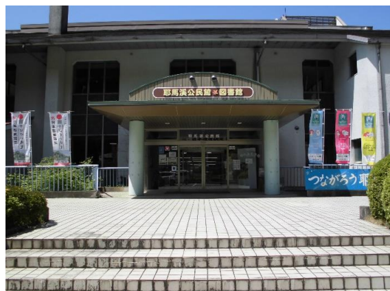
国道212号線沿いから耶馬溪図書館が入っている建物が見えます。
